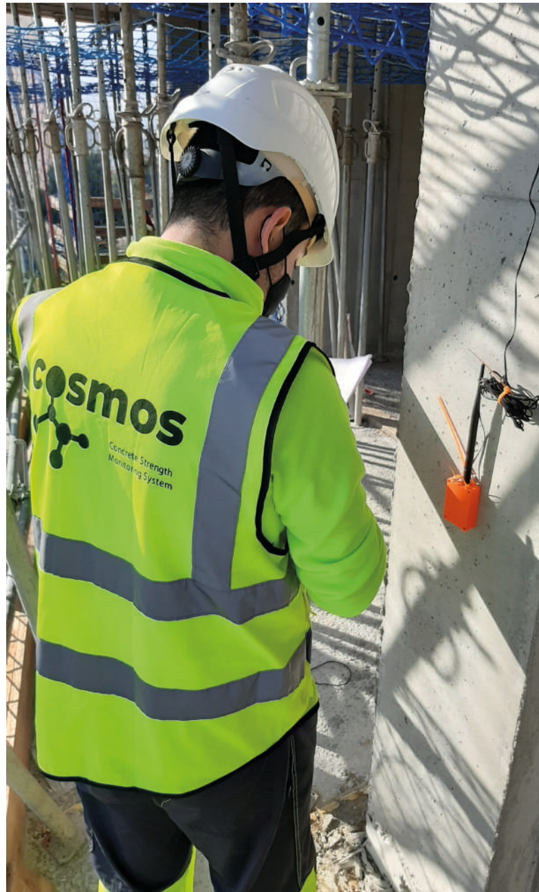
Operario de CoSMoS™ instalando sensor
